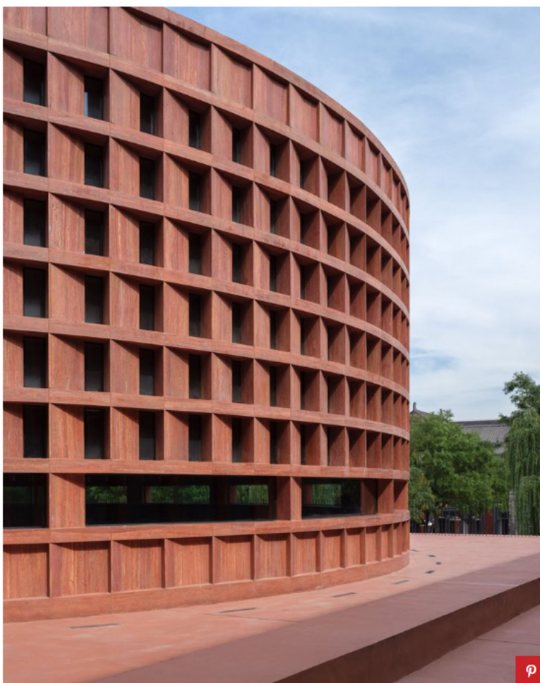
La struttura del Monumento è in cemento con elementi in travertino rosso
