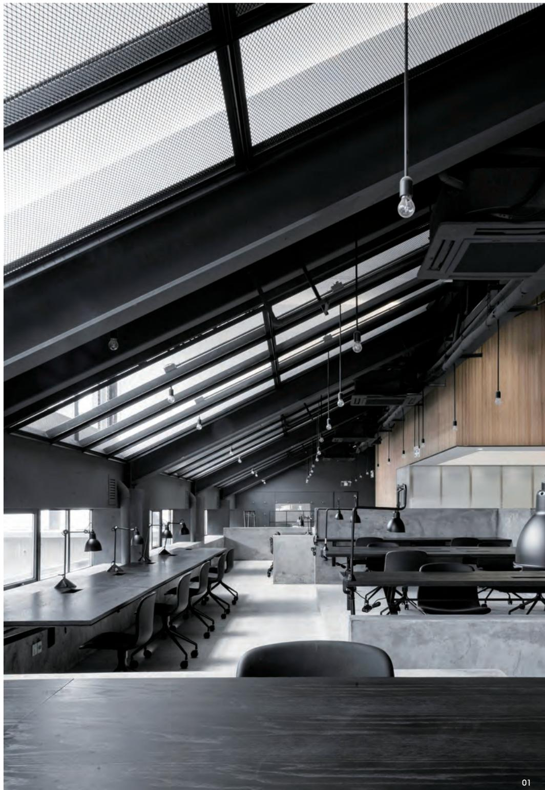
空间内的平面屋顶通过附加的 A 框钢架结构转换为可用的空间，屋檐内如同一个阁楼，增加并提升了现有的体验，房屋状的体块嵌入混凝土平台，打破了均匀的空间，如此一来，屋顶不只是单一的元素，还可以从不同位置体验空间的多个层面。
