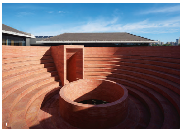
1. 曲江艺术博物馆扩建部分为悬浮于基座功能体块之上的户外圆形剧场，纯粹的几何构成凸显建筑的纪念性。光线可以照射到下庭院。2. 立面采用红洞石材料，菱形单元体间隔排列，为室内提供更为戏剧性的光影效果。
